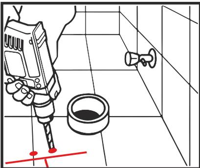
Entsprechend der Markierung die vorsichtig die Bohrlöcher bohren.
